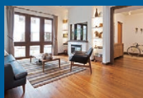
無垢板のフロア 無垢の木の風合いがもたらす心地よさはそのままに、 反り・くいを軽減させた3層構造の「三層フロア」
